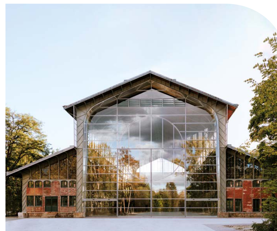
Hangar Y, Meudon (92) La réhabilitation de cet ancien hangar à ballons dirigeables en un lieu culturel et événementiel illustre un savoir-faire en matière de réhabilitation complexe et d'innovation programmatique.
